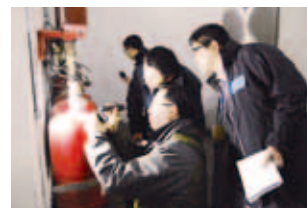
上海轨道交通网络运营安全评估小组专家进行夜间站点安全查勘
