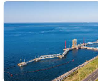
天津港口枢纽基础设施建设项目
